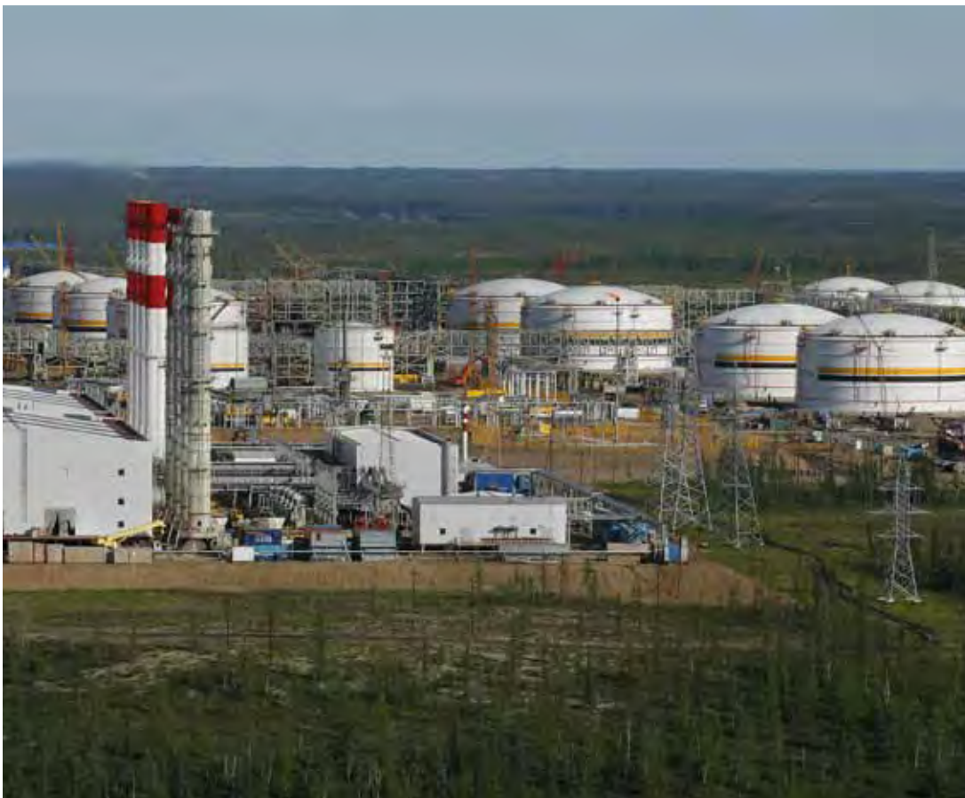
■ Освоение Ванкорского месторождения. Центральный пункт сбора нефти. Июль 2010 г.
