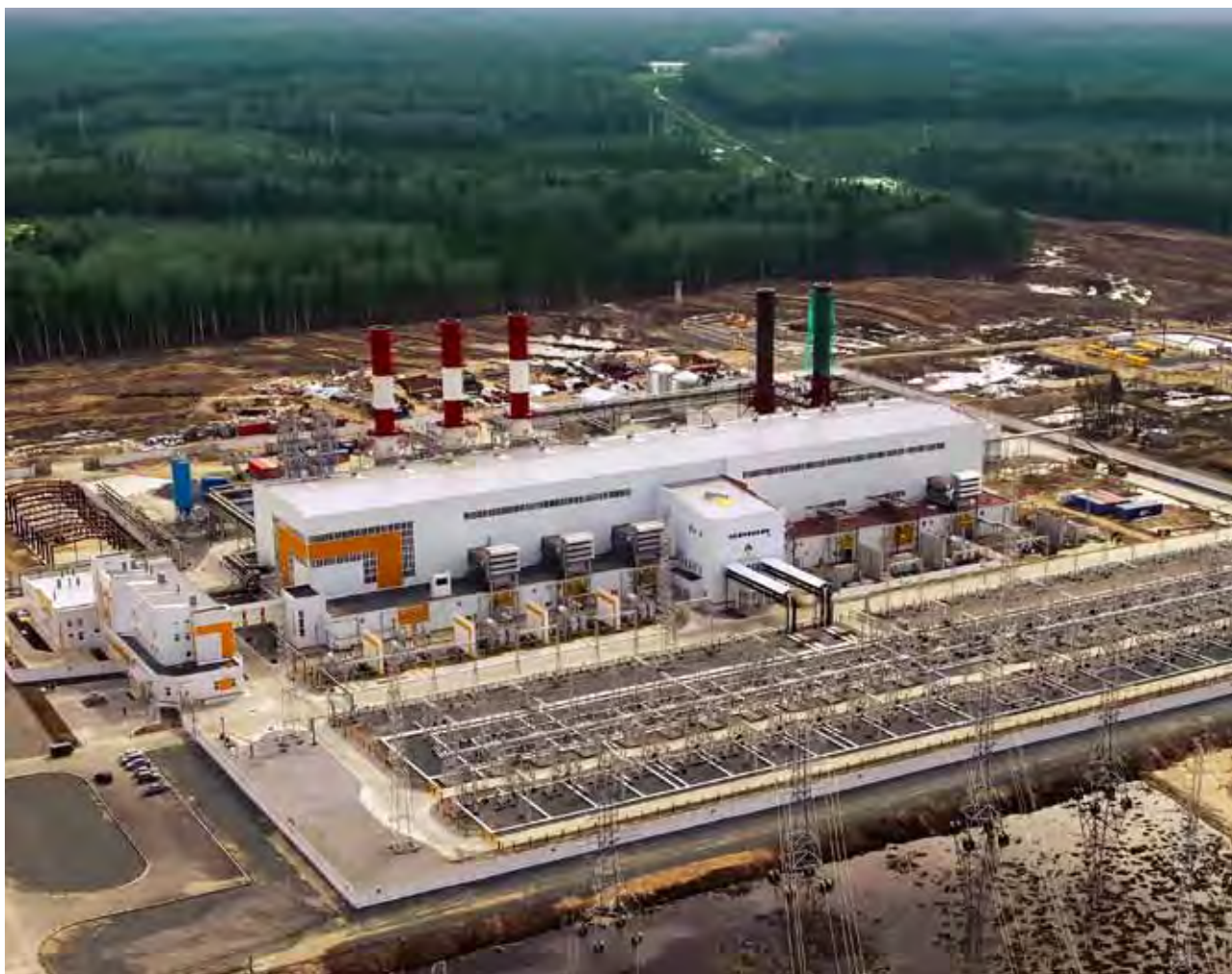
■ Западная Сибирь. ГТЭС-1 на При- обском месторож- дении в ХМАО
