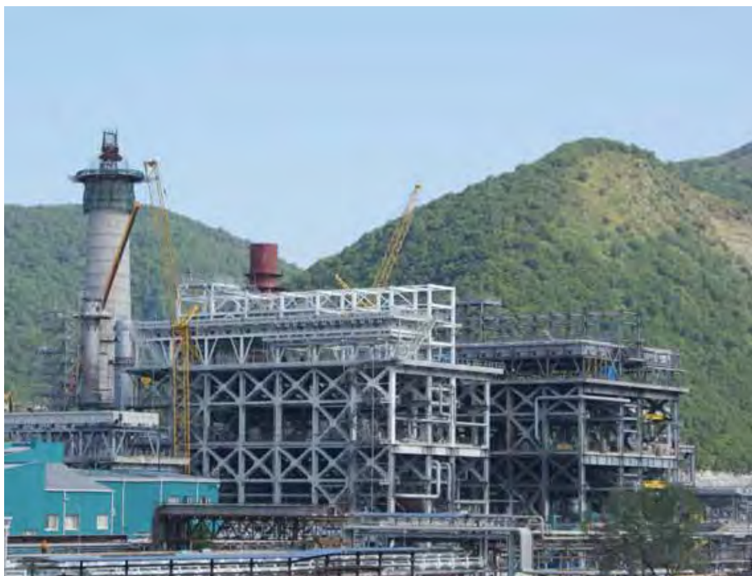
Туапсинский НПЗ. Строительство установки ЭЛОУ-АВТ-12
