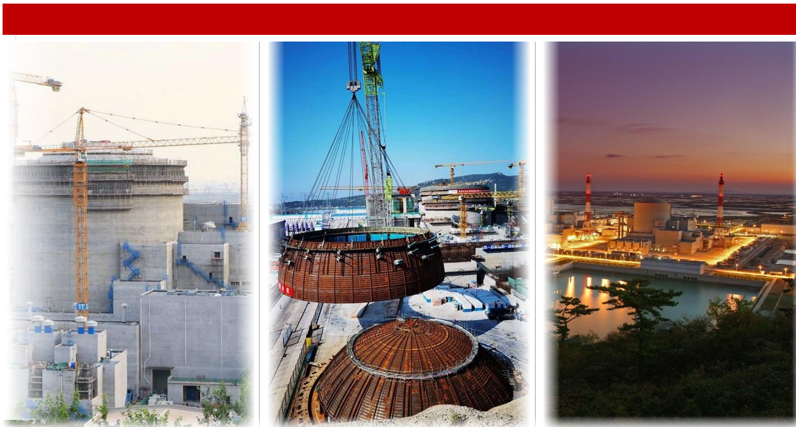
Строительство АЭС «Тяньвань» и «Сюйдапу» в Китае
